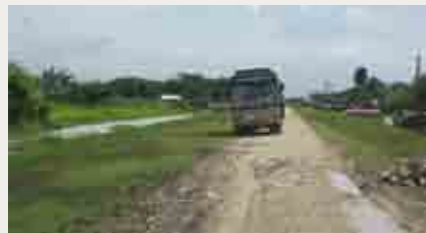
舗装が貧弱なので雨が降るとすぐに穴があき、でこぼこになる道路。走行中のバスが傾いてしまうことも。
