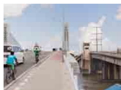
右手に見えるのは1920年代に架けられた旧タケタ橋。改修されながら使われていたが老朽化し、また片側1車線で渋滞の原因にもなっていた。
