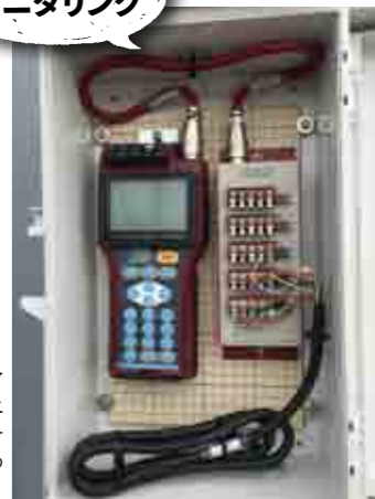
タワーが傾いたトンテイ橋。タワーの上部にモニタリングのための傾斜計を付けて、1年以上にわたって傾斜を計測する。
