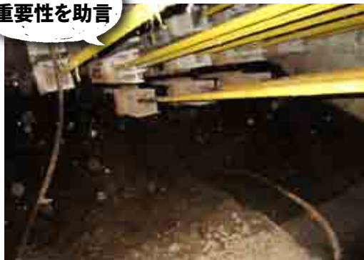
トンテイ橋のアンカー部分。定着部付近に滞水が確認された。トンテイ橋のアンカーには腐食は見られないが、今後を考え、溜まった水を排出できるような対策が必要と提案した。
