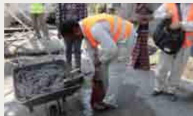
第2フェーズでは、コンクリートによる、より品質の高い舗装技術が使われた。
