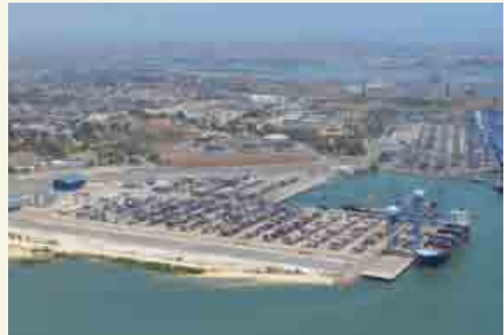
「モンバサ港開発計画」で整備した新コンテナターミナル (写真提供:東洋建設)
