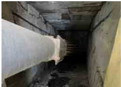
トンテイ橋のアンカー部分。定着部付近に滞水が確認された。トンテイ橋のアンカーには腐食は見られないが、今後を考え、溜まった水を排出できるような対策が必要と提案した。
